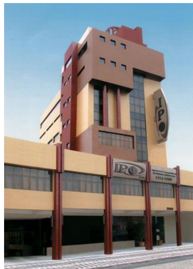
Figura 1 - Fachada Hospital IPO
