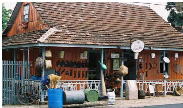
Figura 4 – Fachada do imóvel
