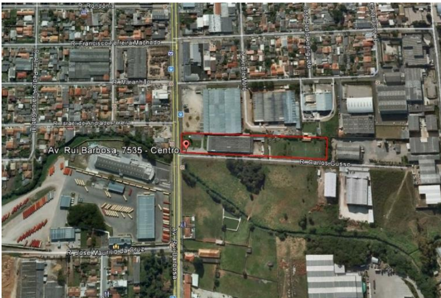
Figura 6 – Imagem aérea do local.
