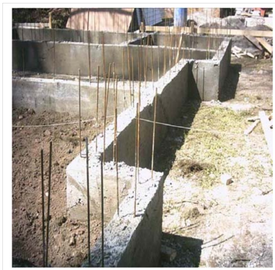
Figura 11– Armaduras de arranque em viga baldrame. Fonte: www.monoplac.cl/
