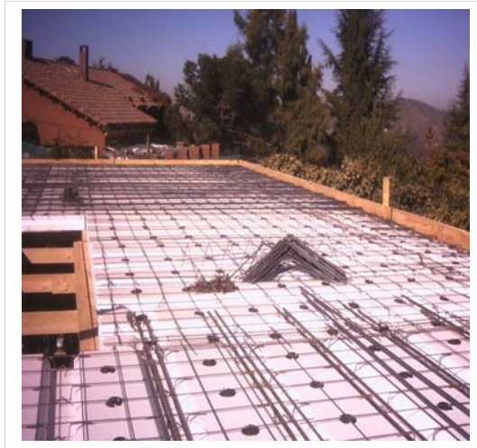
Figura 19 - Laje armada antes da concretagem. Fonte: www.monoplac.cl
