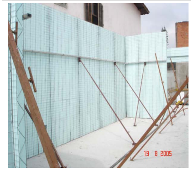
Figura 15—Detalhe de escoramento
