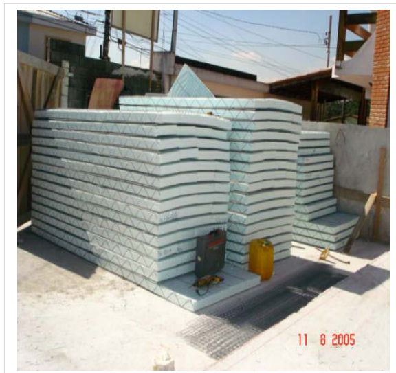
Figura 12– Painéis armazenados em obra. Fonte: Luciano Veronezi (2005)
