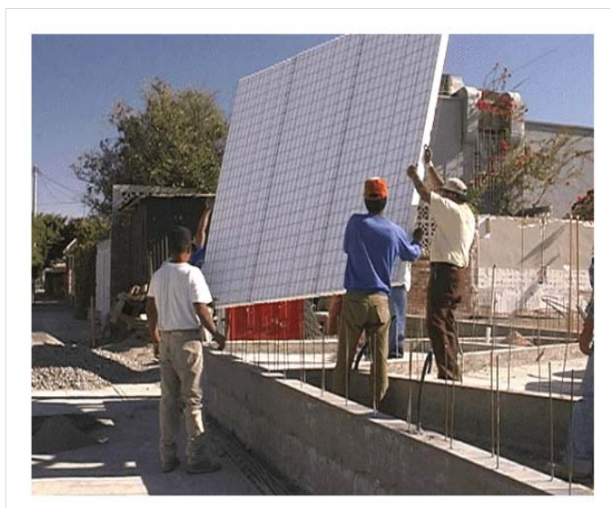
Figura 13– Fixação dos painéis. Fonte: www.monoplac.cl
