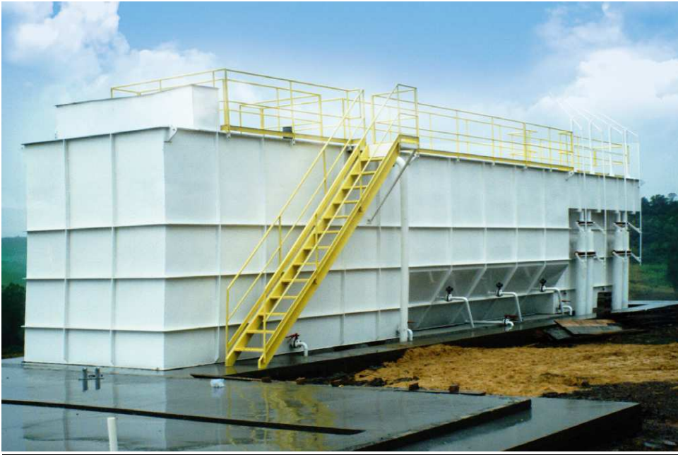
Foto 1 – Eta Engenharia. Fonte: As autoras.
