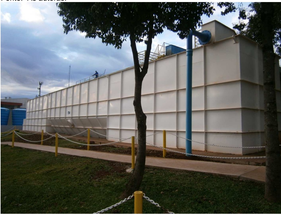
Foto 2 – Eta Engenharia. Fonte: As autoras.
