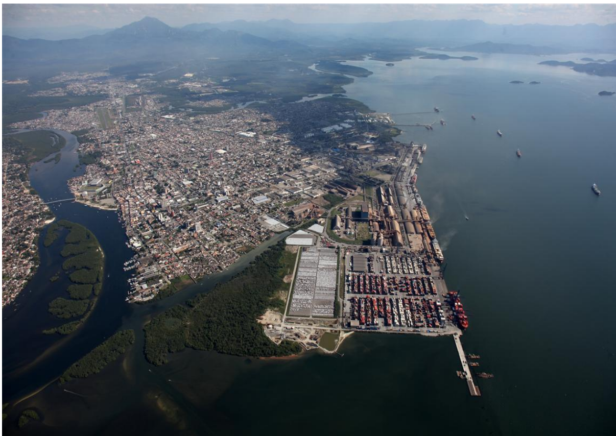
Figura 6 - Porto de Paranaguá.
