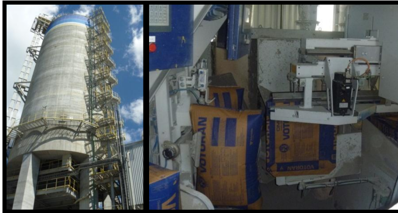
Figura 9 - Ilustrativo de Sistema de Extração de Cimento Fonte: Arquivos Votorantim
