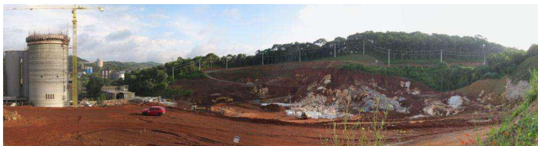
Figura 31 - Visão geral de Terraplanagem de Parte do Projeto Fonte: Arquivos Votorantim.
