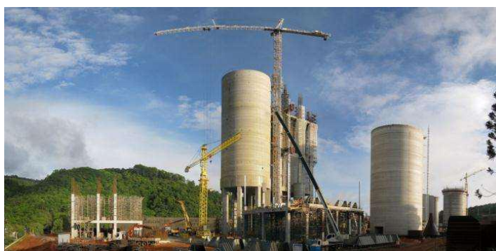
Figura 30 - Visão geral do Empreendimento – Detalhe Guas Fonte: Arquivos Votorantim
