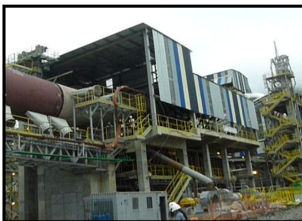
Figura 6 - Sistema de Resfriamento de Clinker Fonte: Arquivos Votorantim
