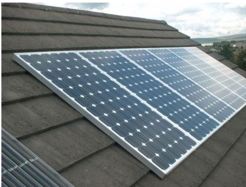
Figura 9: Painel solar em cobertura de residência.
