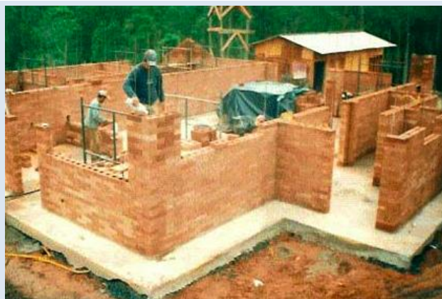
Figura 5 – Aplicação do tijolo de solo-cimento
