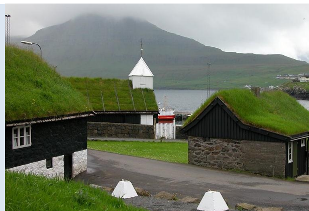
Figura 3 – Telha verde das residências nas ilhas Faroe, localizadas na Dinamarca
