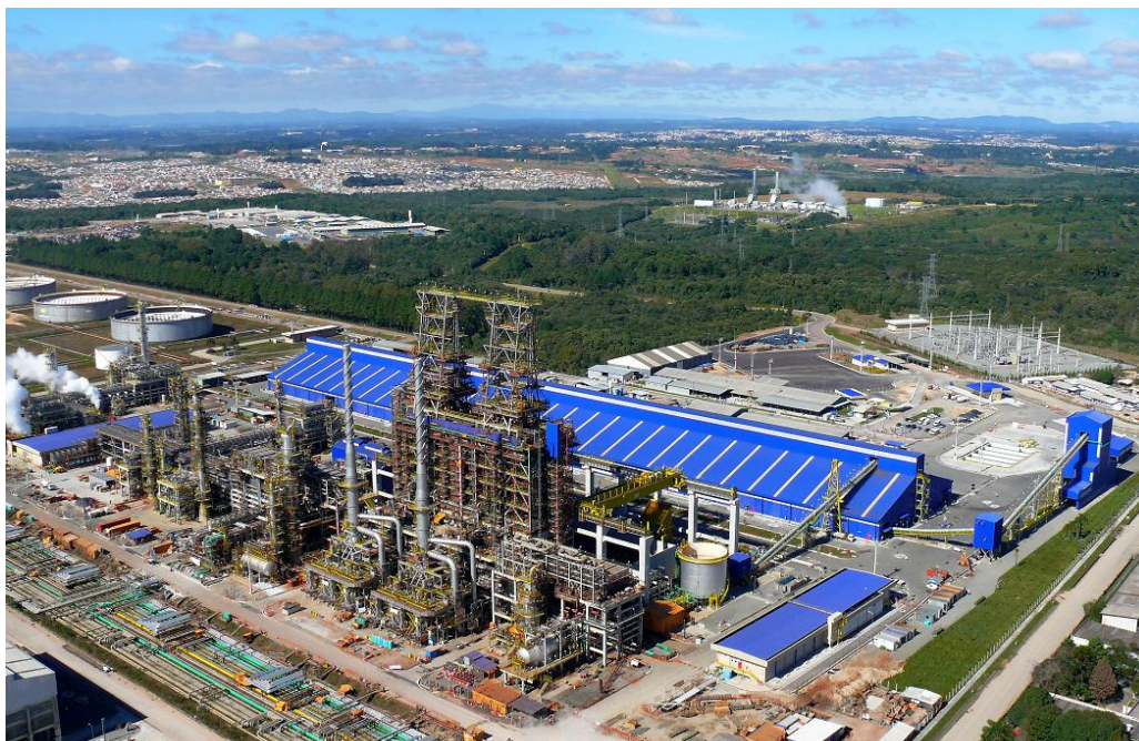
Panorâmica Unidade de Coqueamento Retardado na Refinaria Getúlio Vargas – Araucária – Paraná 2012
