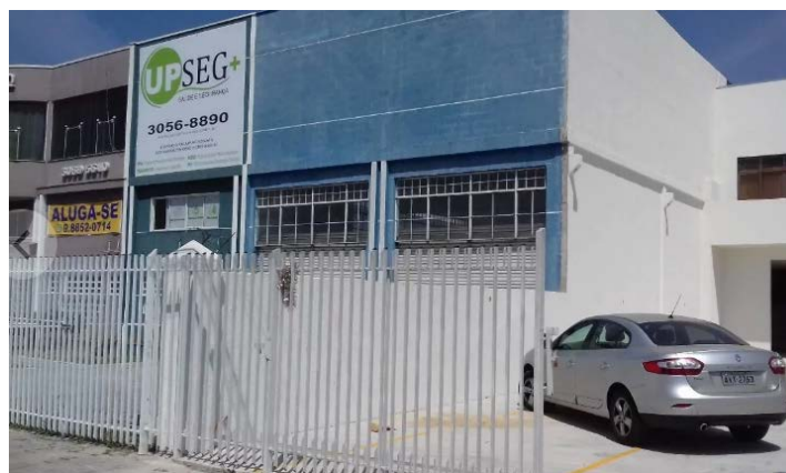
Figura 2 – Fachada Externa da Loja
