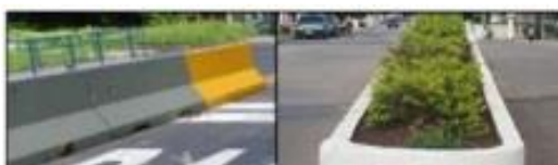
FIGURA 14 – EXEMPLOS DE DIVISORES DE FLUXO – BARREIRA NEW JERSEY E CANTEIRO CENTRAL
