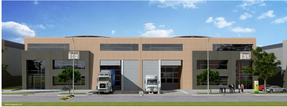
Figura 8 - Fachada da nova fábrica
