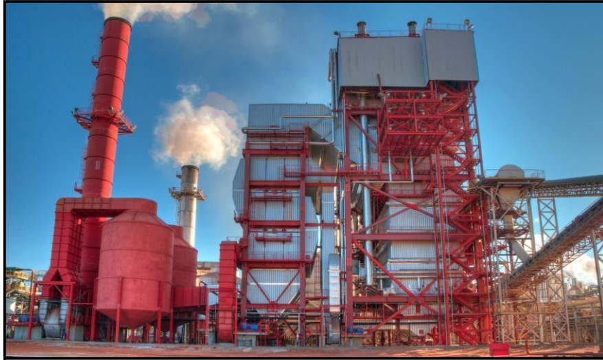
Figura 2. Visão externa caldeira em termelétrica.
