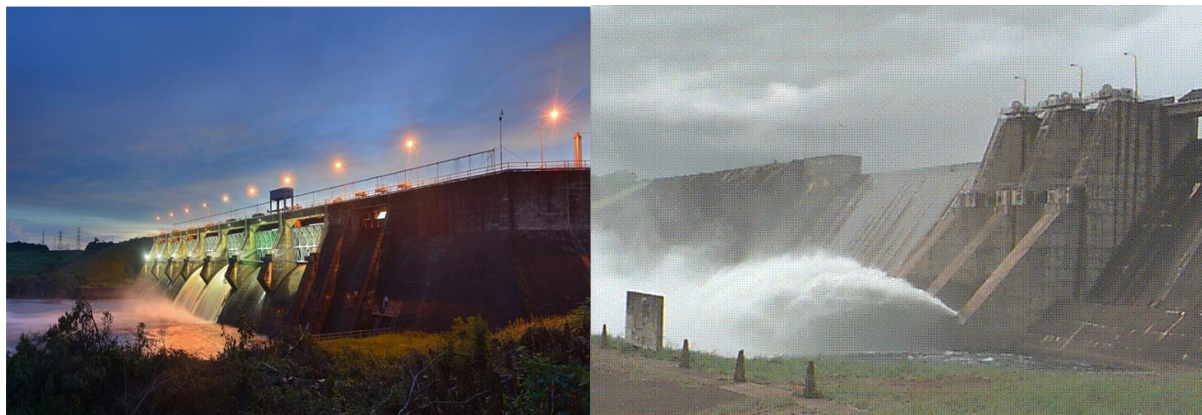
Figura 5. Central Hidrelétrica de Acaray e Reservatório de Yguazú.
