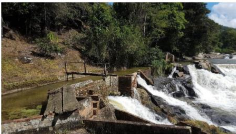
Figura 17: Canal de adução existente – Vista de jusante, a partir da casa de força Fonte: Autoria Própria
