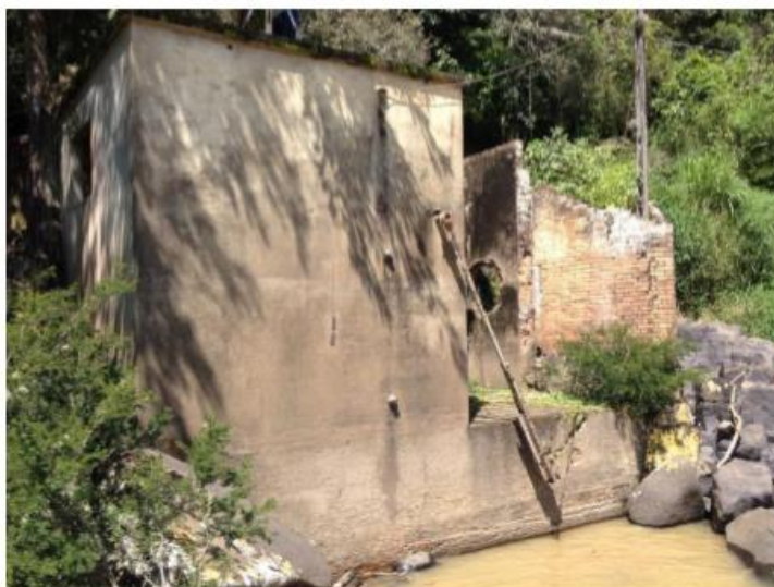
Figura 19: Casa de força existente – vista a partir de jusante, do leito do rio.
