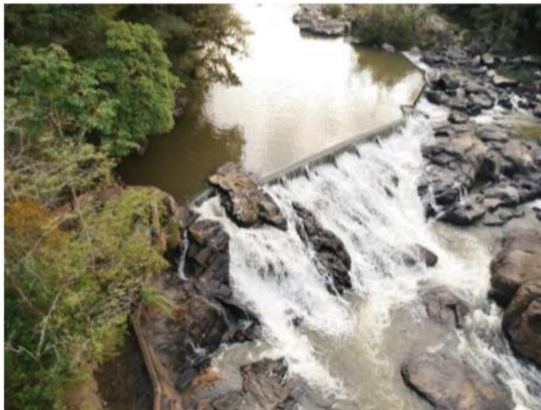
Figura 13: Barramento e Tomada de Água Existentes
