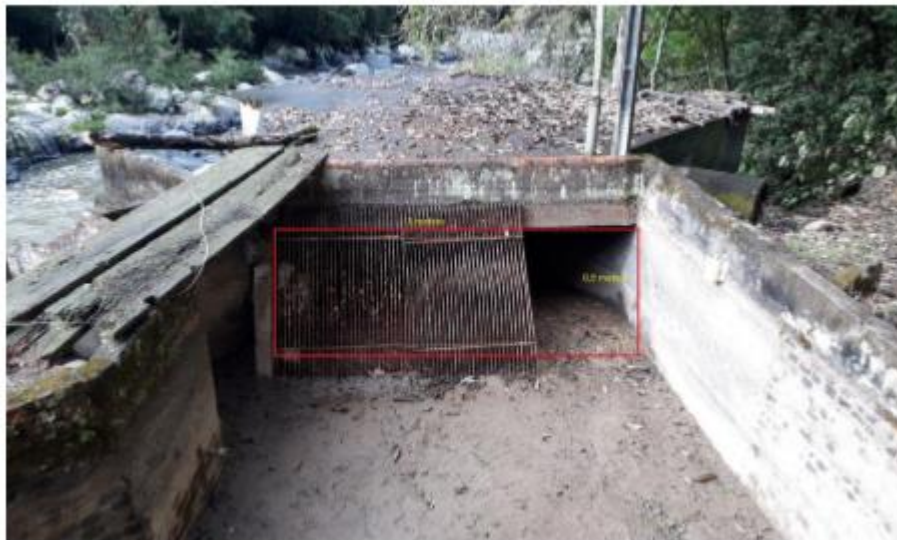
Figura 18: Grade da entrada da casa de força existente
