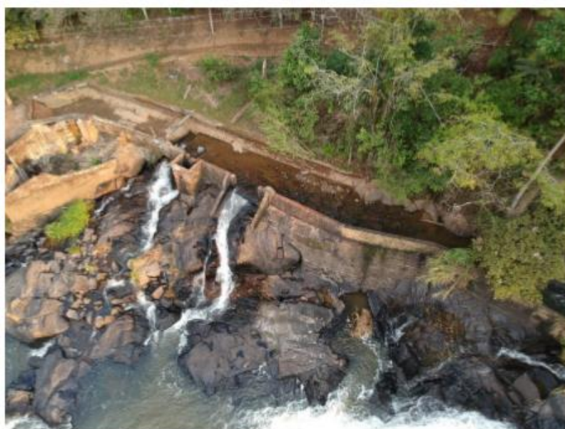
Figura 16: Canal Adutor Existente
