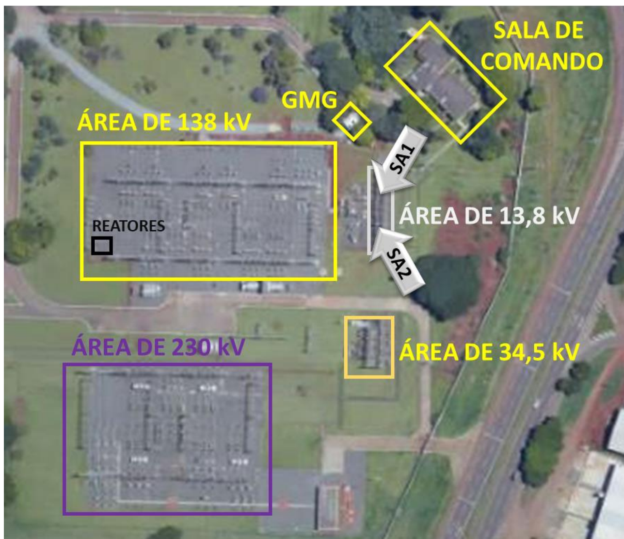
Figura 16: Subestação Maringá 230 kV Fonte: Própria (2018).
