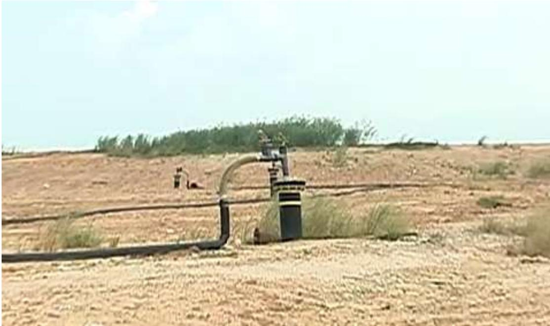
Figura 10 – Saída das tubulações para captação do Biogás
