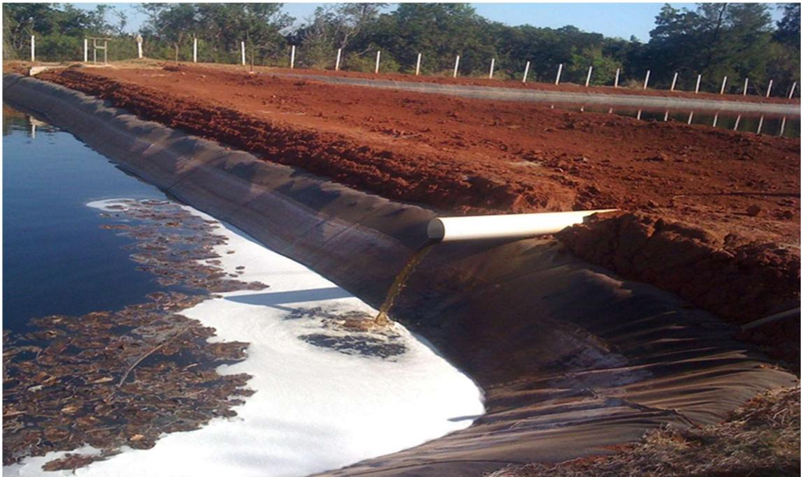
Figura 33 – Tanque de tratamento de chorume do Aterro Sanitário de Goiânia
