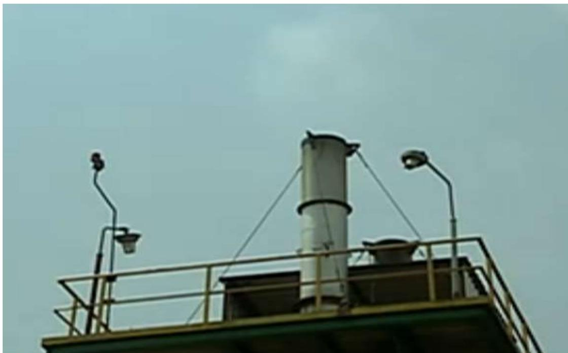
Figura 30 – Chaminé de exaustão dos gases do processo
