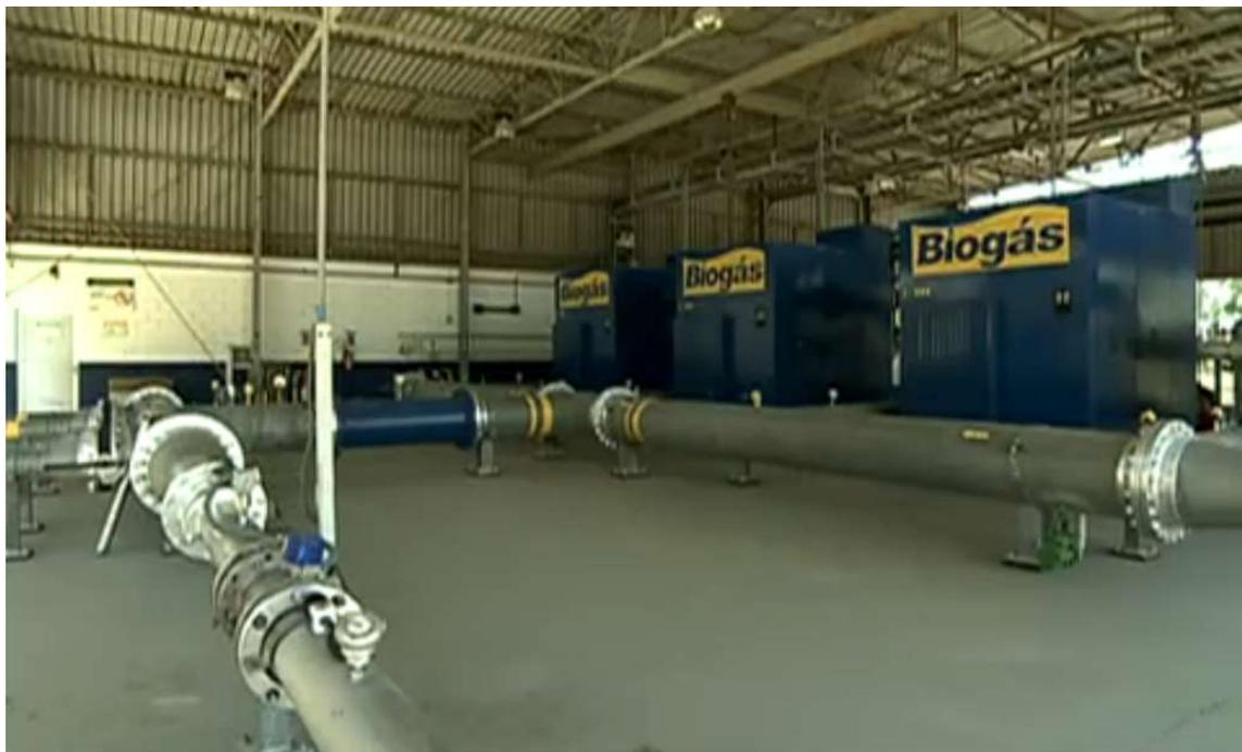
Figura 11 – Compressores para captação do Biogás
