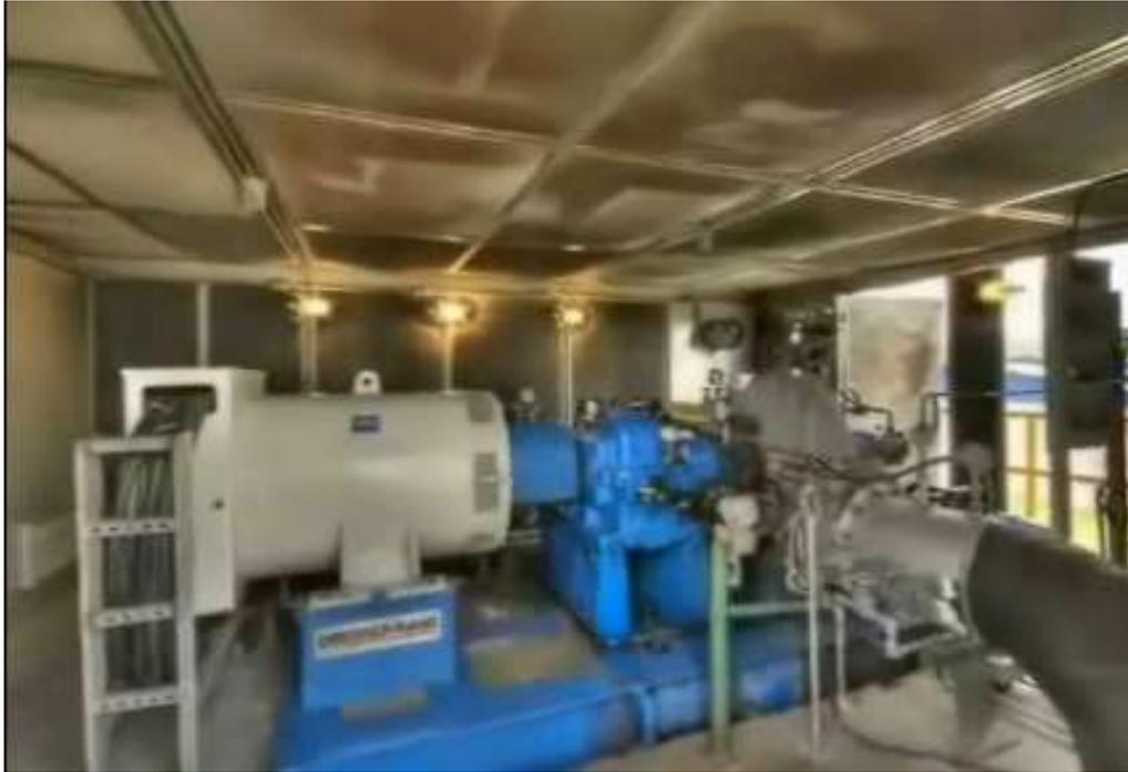
Figura 27 – Gerador e turbina a vapor
