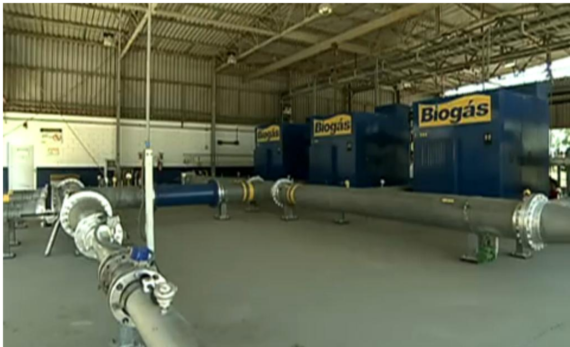
Figura 10 – Compressores para captação do Biogás Fonte: Globo News, 2013.
