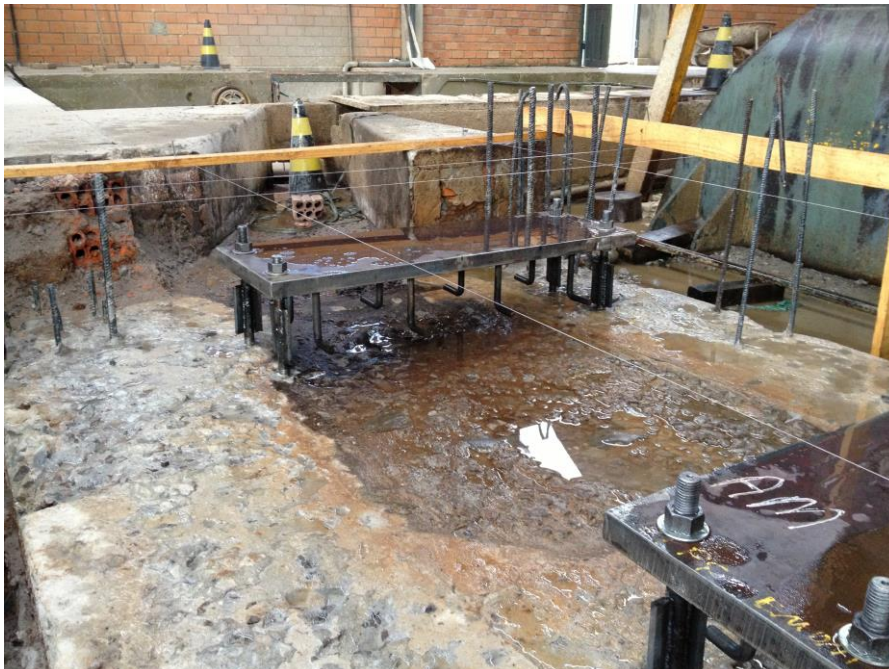
Fixação de chapa para sustentação gerador 1
